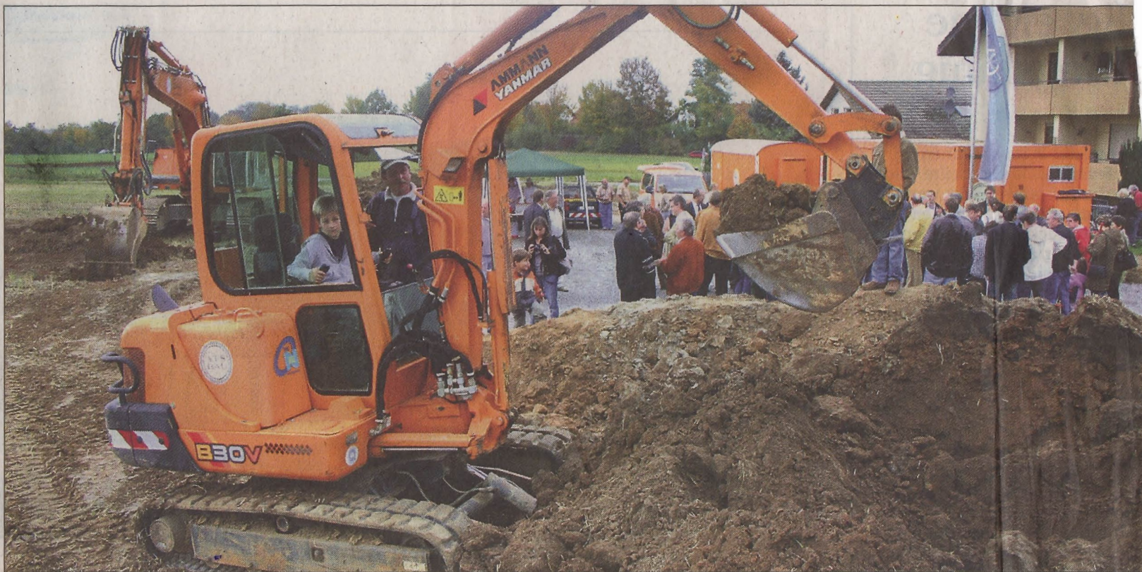
Tobias Bonomini durfte gestern unter Anleitung von Michael Rauer den Baggerbiss im Neubaugebiet machen.
